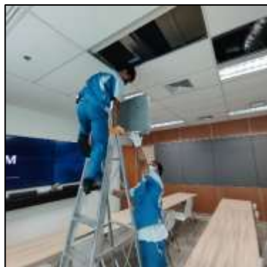
ภาพที่ 4 กิจกรรมทำความสะอาดระบบปรับอากาศ
