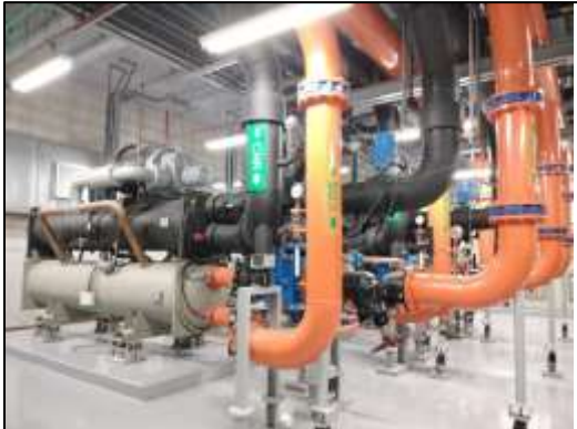
ภาพที่ 6 ระบบระบายอากาศแบบจ่ายน้ำ จากส่วนกลาง
